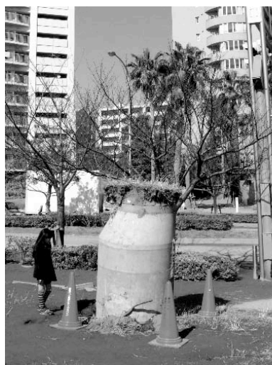
写真：液状化した浦安市で 飛び出したマンホール
