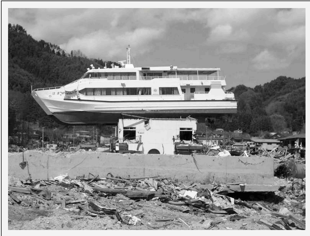
津波によって打ち上げられ、ビルに乗り上げた観光船（岩手県大槌町）
