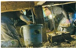
床下にもくった泥出し作業
